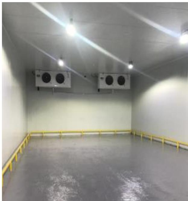
Imagen 17. Cámaras de paneles aislados térmicamente.
